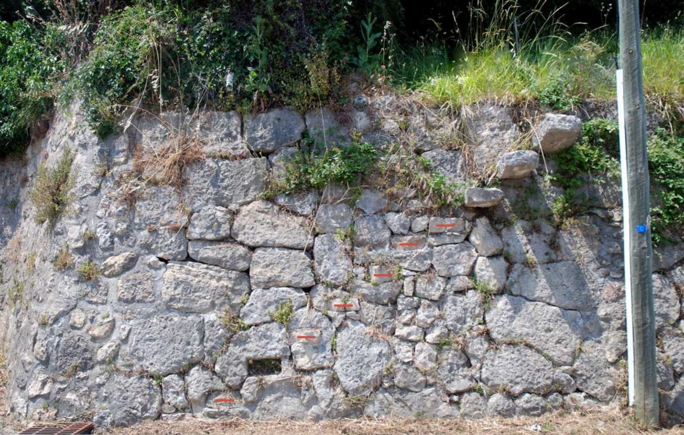
Route Jean Natale - Ancien escalier volant dont 7 pierres de marches en saillie sont sectionnées.
