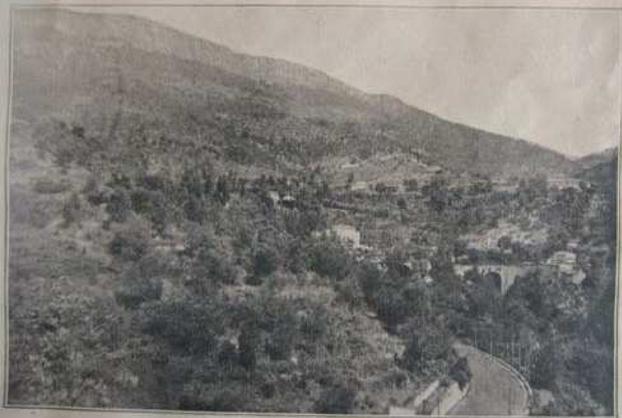
Vue d'ensemble d'une partie du Domaine
